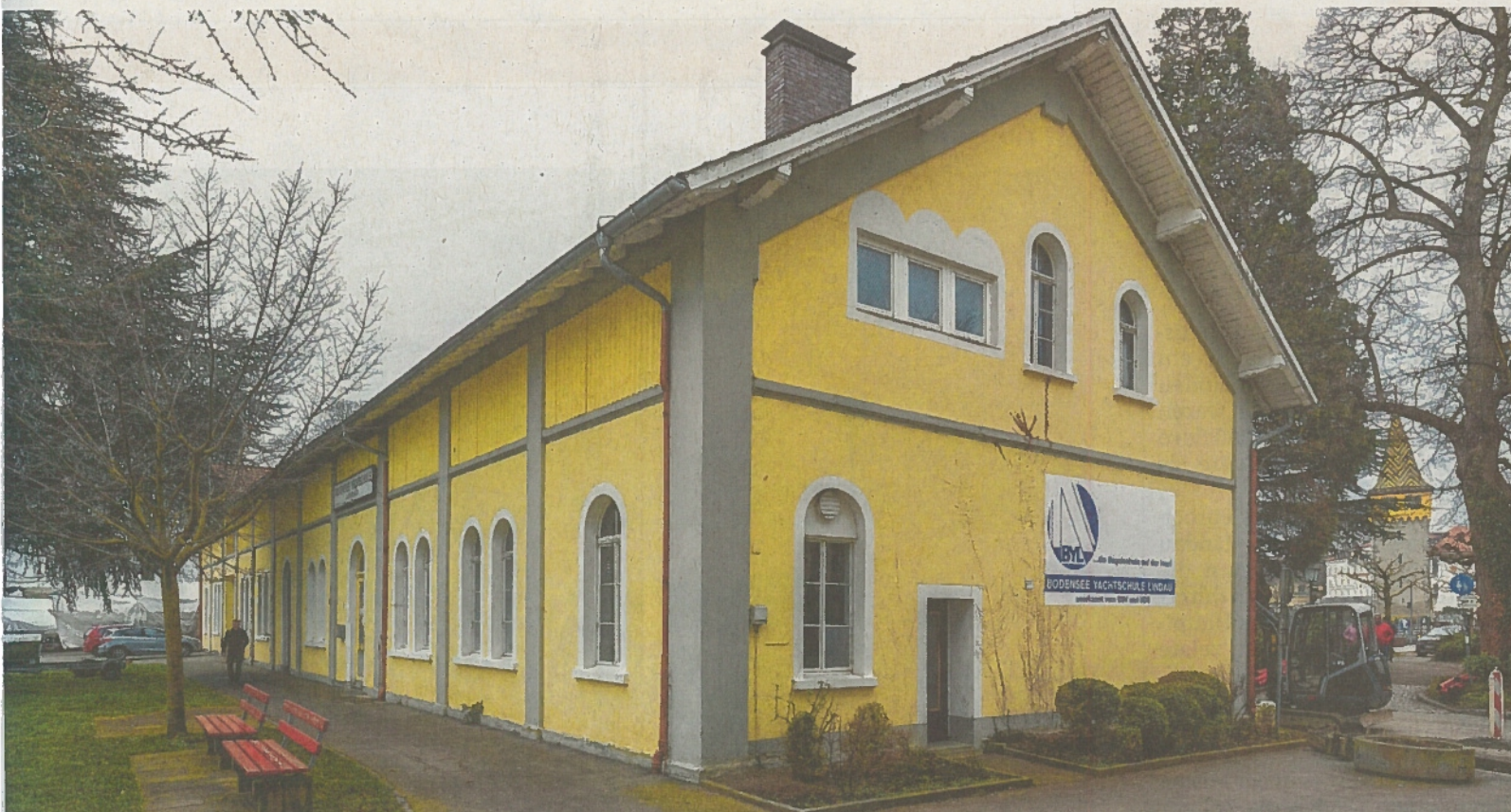
Der Lindauer Seglerclub möchte in der Schiffswerft ein neues Jugend- und Ausbildungszentrum entstehen lassen. Dafür muss das denkmalgeschützte Gebäude aber erst saniert werden. Noch unklar ist, wann diese Sanierung beginnt. FOTO: CHRISTIAN FLEMMING
